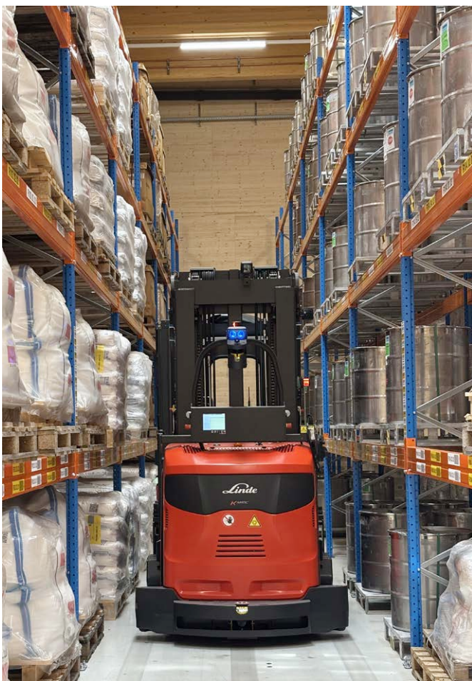
Das fahrerlose Schmalgangfahrzeug übernimmt die automatisierte Ein- und Auslagerung im Hochregallager von Kyocera und sorgt für stabile Materialflüsse auf engstem Raum. Fotos: AKL-tec
